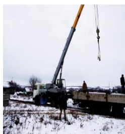
Будівництво Адамівської СЛІА
