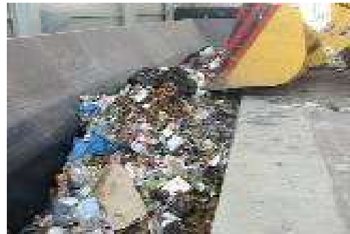
Накопичувальний стрічковий конвеєр (під підлогою)
